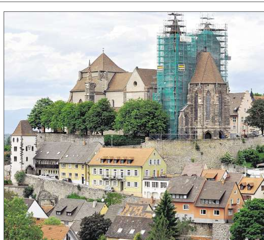
Das Wahrzeichen der Stadt Breisach, das romanisch-gotische Stephansmünster, wird seit dem Jahr 2005 außen saniert. Mit den Arbeiten an den beiden Türmen geht die Maßnahme in ihre letzte Phase. Foto: Haid
